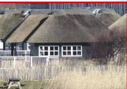
37 reetgedeckte Hütten von Hvidbjerg Strand stehen in einem künstlichen See
